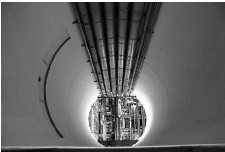
РИС. 29. Взгляд вниз, в «гнездо» для детектора ATLAS, со специальной платформы наверху. Видны трубы, по которым вниз доставлялись детали и строительные материалы
